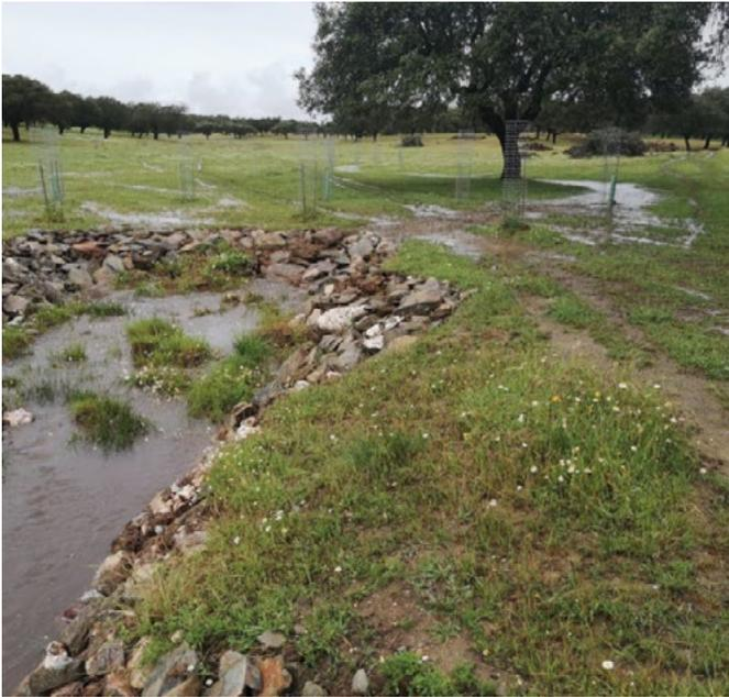
Formación de una cárcava debido a la escorrentía del agua en una vaguada después de una fuerte precipitación. Se han añadido piedras para proteger los márgenes de la cárcava y evitar la erosión remontante.
