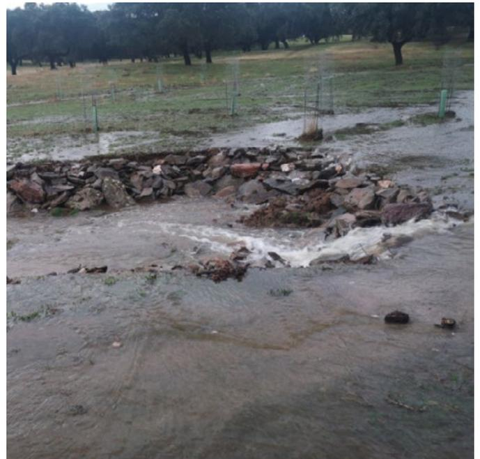
Para reducir los efectos erosivos, la solución más adecuada es la construcción de barreras a la libre progresión del agua, especialmente donde hay desniveles más marcados que aumentan el daño erosivo.
